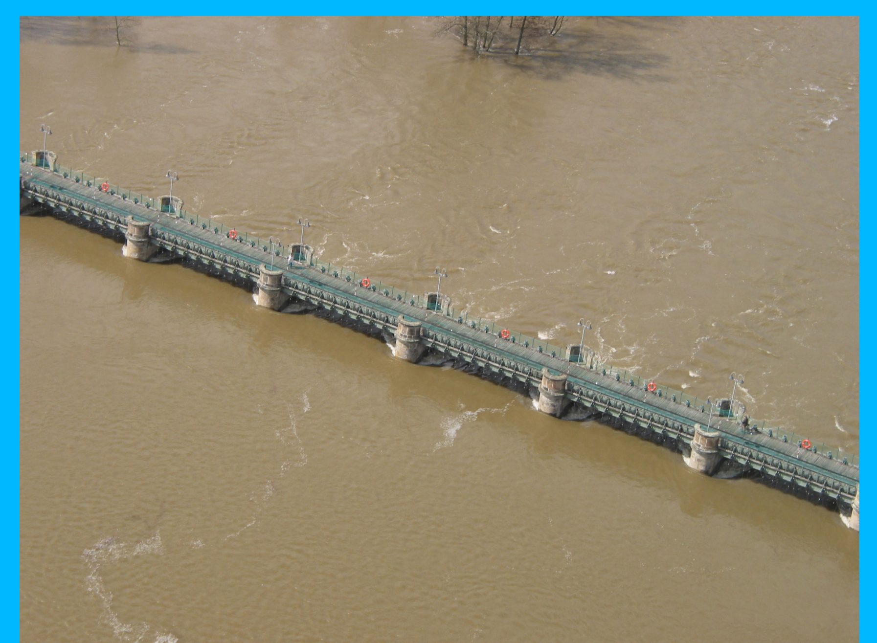
Elbehochwasser 2006, geöffnetes Pretziner Wehr (Foto: ARGE Elbe) Bei Hochwasser können durch das geöffnete Pretziner Wehr und den 27 km langen Elbeumflutkanal (1871-1875 gebaut) ca. 1000 m³/s Elbewasser östlich um Schönebeck und Magdeburg herumgeleitet werden. Bislang erfolgten 63 Wehröffnungen.
